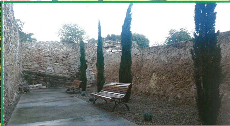
Pozo de la Nieve, antiguo nevero situado dentro del municipio construido mediante la técnica de piedra en seco.
